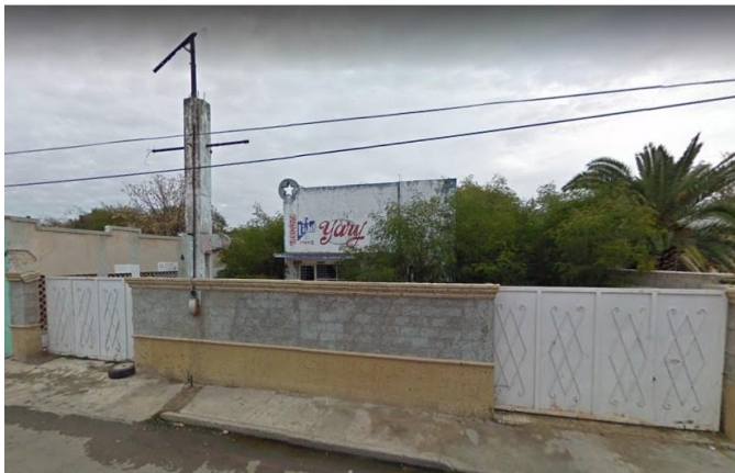
Una vieja cantina abandonada adentro de un terreno en el barrio de San Judas. Fuente: Fotografía propia
