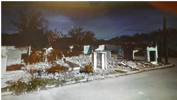
Vecindades demolidas en el barrio de San Judas Tadeo. Fuente: foto histórica de Google maps
